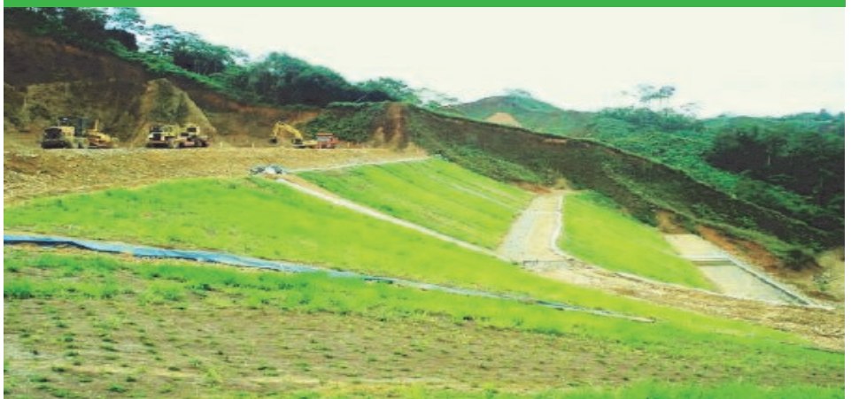
Talud revegetado con Hidrosiembra, un mes después
