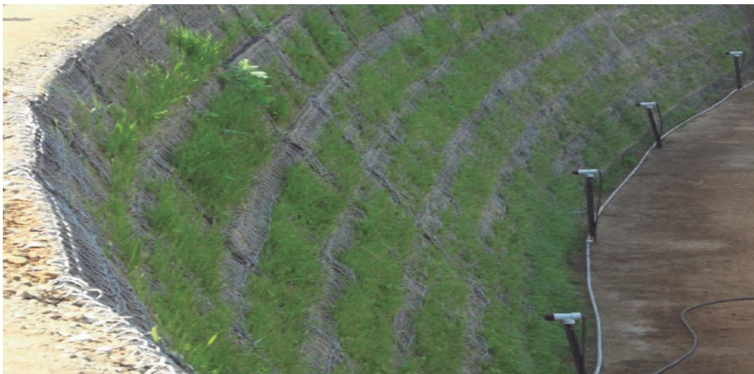
Fotografía 4: Vista general del resultado de la Hidrosiembra luego de un mes.
