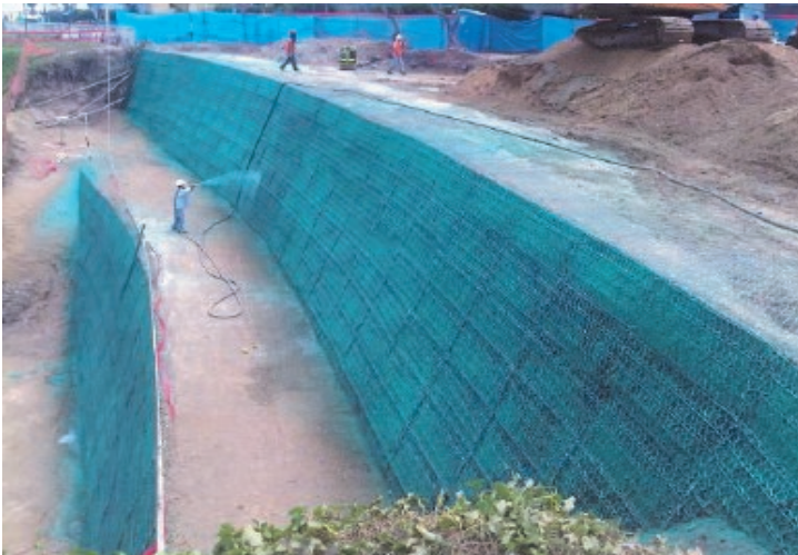
Fotografía 2: Aplicación de Hidrosiembra sobre lado frontal de terramesh.
