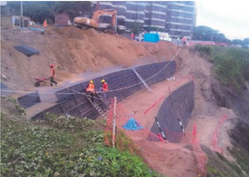
Fotografía 1: Sistema de terramesh casi finalizado y sin revegetación.
